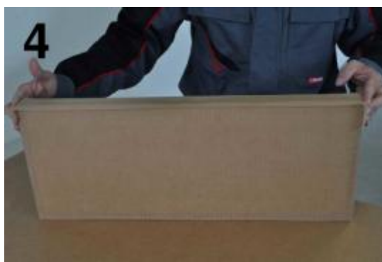
4 Pečlivé přelepení desky páskou Wolf Tape v rozích.
